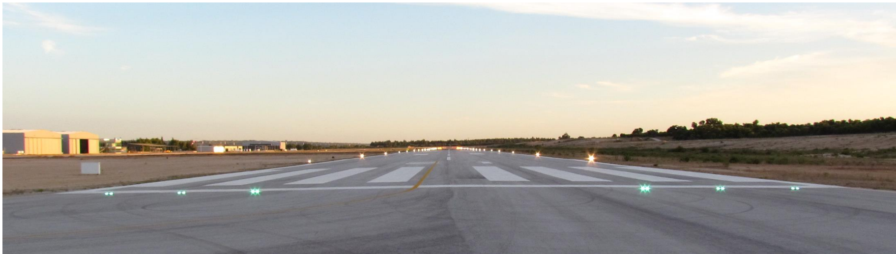
Soleira, Laterais de pista (Ponte de Sor)
